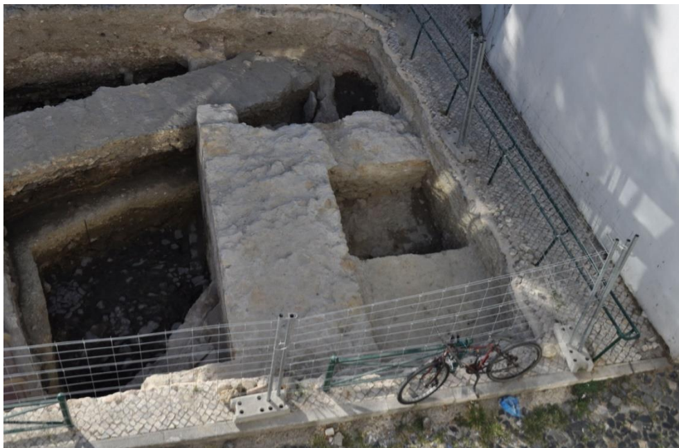
13 – VISTA DA TORRE, AO CENTRO, A PARTIR DO EDIFÍCIO DO BECO DO BELO (NOROESTE)
