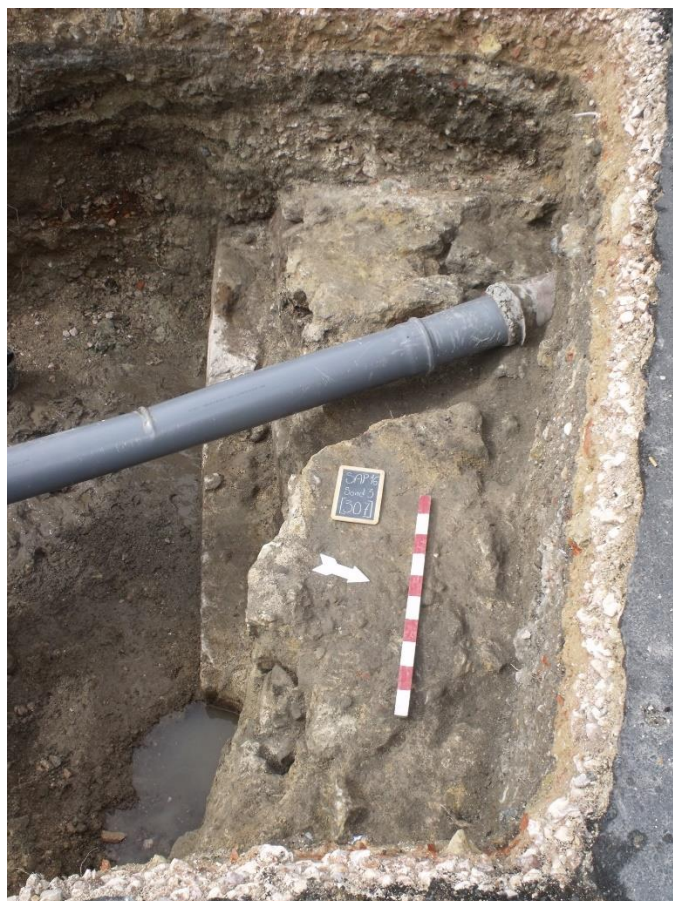
36 - [307] VISTO DE ESTE, NOTANDO-SE O ROUBO DA SILHARIA DA FACHADA EXTERNA E TOPO
